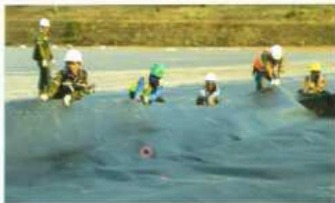
**ATARFIL HD** mengandung 97.5 % polymer HDPE murni dan sekitar 2.5 % carbon black, anti oksidan, & thermal stabilizer. **ATARFIL HD** tidak mengandung plasticizer atau *filler* yang dapat mencemari cairan yang ditampung dalam kolam.
